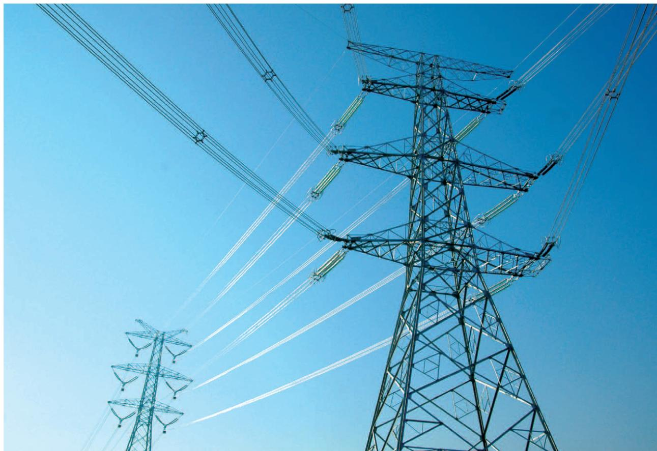
上海电力送变电工程公司从事上海外高桥电厂的三期工程，即在外高桥电厂和上海南汇变电站之间架设电缆。全程大约有40公里。线路为500千伏的交流电网。
