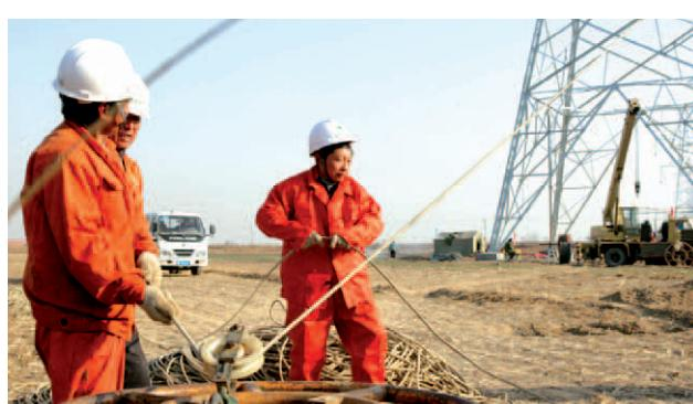
对两家公司而言，显然没有比使用Dyneema®(迪尼玛®)进行电力牵引更好的选择了。使用Dyneema®(迪尼玛®)做成的电力牵引缆具有以下特点：
